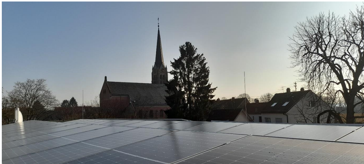
Photovoltaik-Anlage auf der neuen Kita Wallonenstraße
